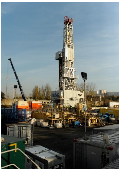
Figure 6 : Machine de forage installée en 2014 sur le puits d'Arcueil (94)
