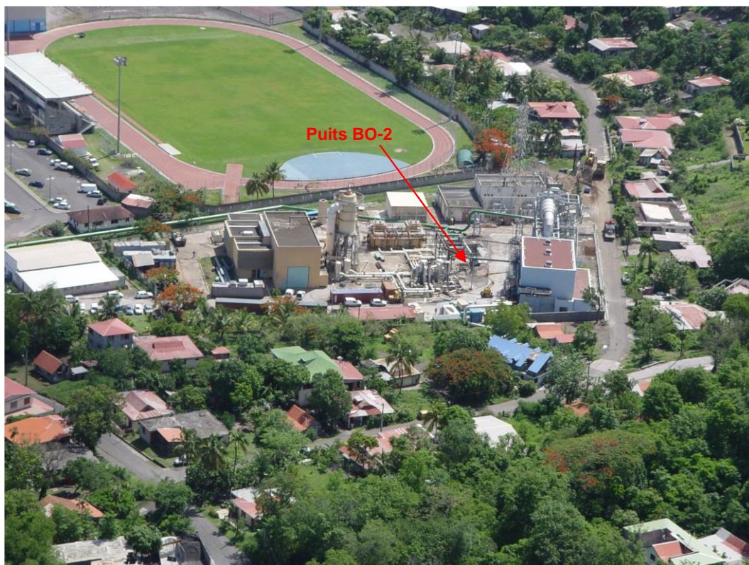
Figure 13 : Photographie aérienne de la centrale géothermique implantée dans le bourg de Bouillante.
