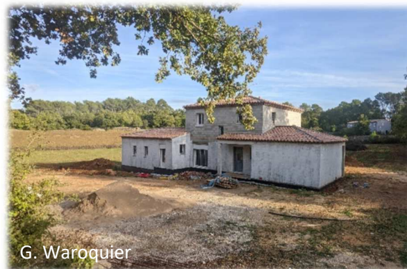
Figure 27. Domicile privé en construction au niveau d'une dépression inondable à Flassans-sur-Issole.
