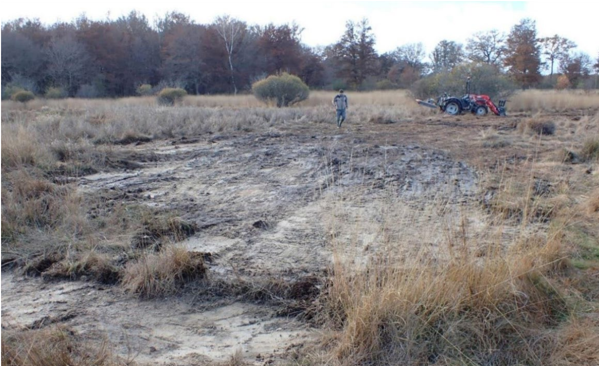
Figure 68 : Aperçu de la station après décapage sur la RNN de l'Etang des Landes (K. Guerbaa – novembre 2021)
