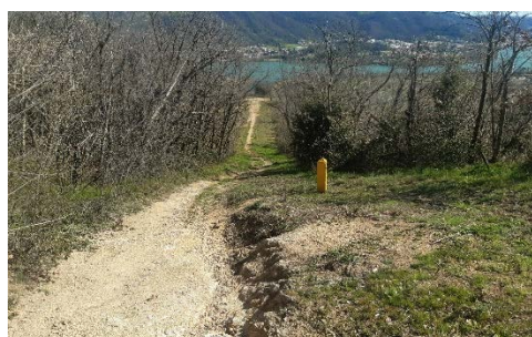
Canalisation de transport de gaz sur la colline de Roche-Vautour © A. AIRD, CBN Massif central
