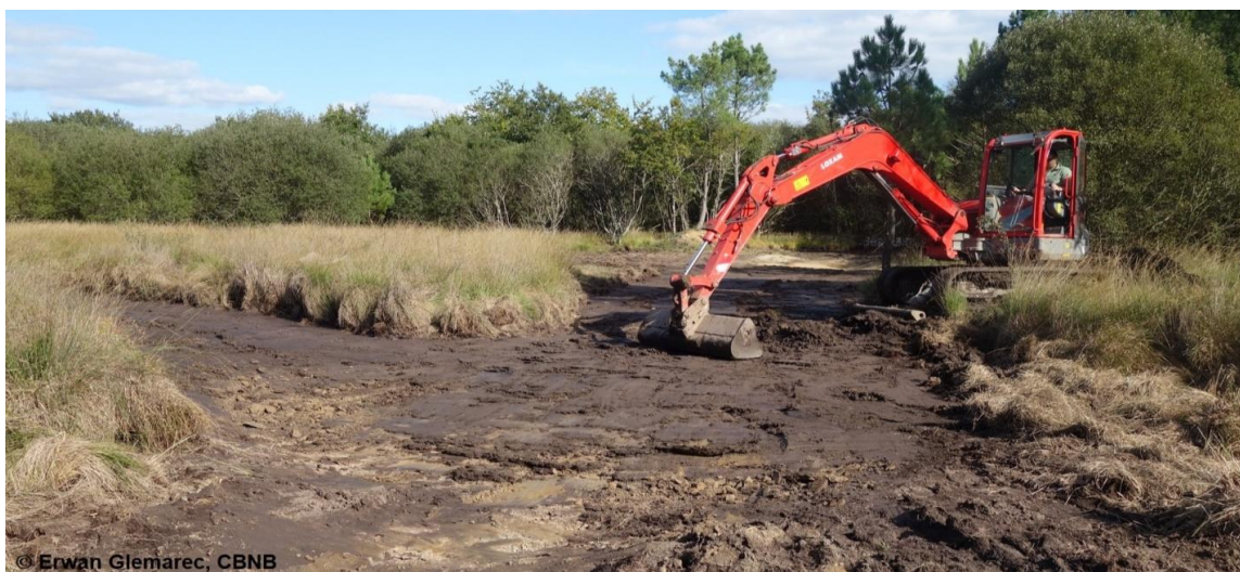
Chantier d'étrépage mécanique sur le site de Saint-Laurent : restauration de milieux pionniers, favorables à Eryngium viviparum .
