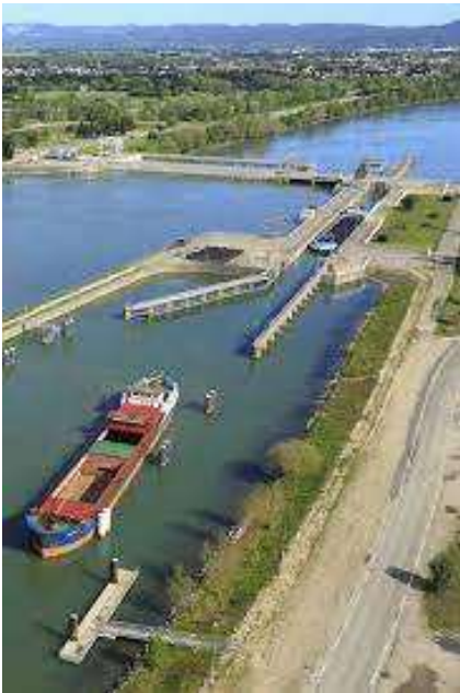
Ecluse sur le Rhône © CNR
