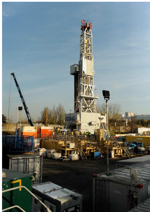
Figure 68 : Machine de forage installée en 2014 sur le puits d'Arcueil (94)
