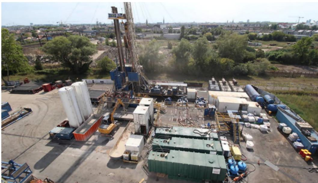
Figure 43 : Machine de forage installée en 2019 sur le projet de Bordeaux-PGE (Plaine de Garonne Energies)
