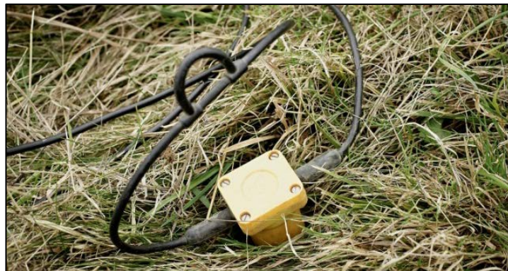
Figure 33 : Déroulage des câbles et pose des géophones © Vermilion
