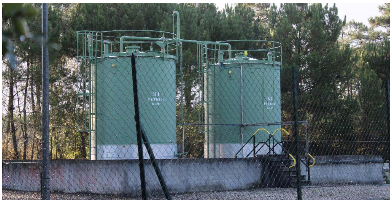
Figure 16 : Bacs de stockage de l'emplacement TMR1
