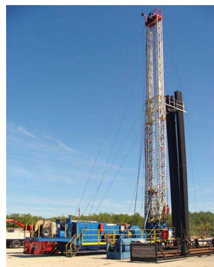
Figure 11 : Appareil d'intervention à l'occasion d'une réparation de puits
