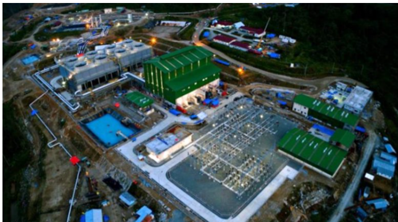
Figure 3: Centrale géothermique ENGIE de Muara Laboh, West Sumatra (Indonésie)
