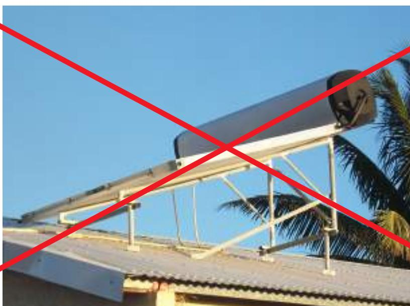
Figure 154 : Exemple à éviter d'installation non parallèle à la toiture et avec système d'ancrage « fait maison »
