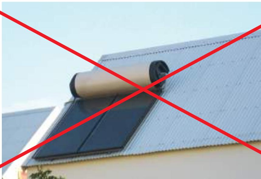
Figure 153 : Exemple à éviter d'installation proche d'une rive
