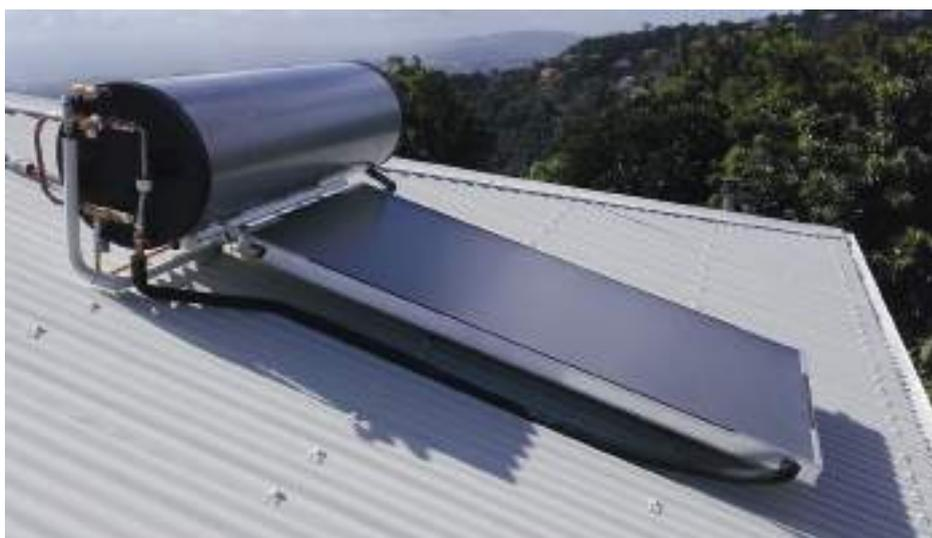
Figure 152 : CESI à thermosiphon sur toiture tôle
