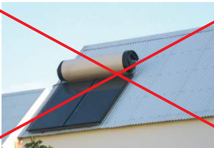
Figure 152 : Exemple à éviter d'installation proche d'une rive
