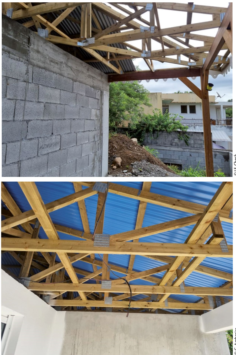
Figure 167 : Photos d'un auvent nécessitant un faux-plafond extérieur en sous-face
