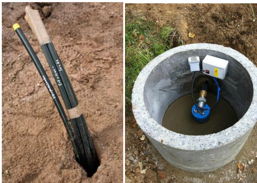
Illustration n° 13 : A gauche, forage de gradient avec sorties des sondes à la fin de la foration et à droite, site pérennisé et sécurisé en surface.
