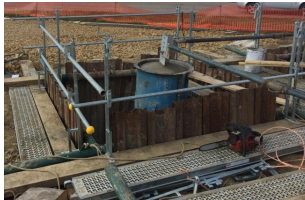
Figure 29 : Fondation de pylône
