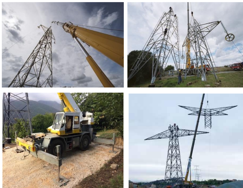
Figure 30 : Levage des pylônes à la grue
