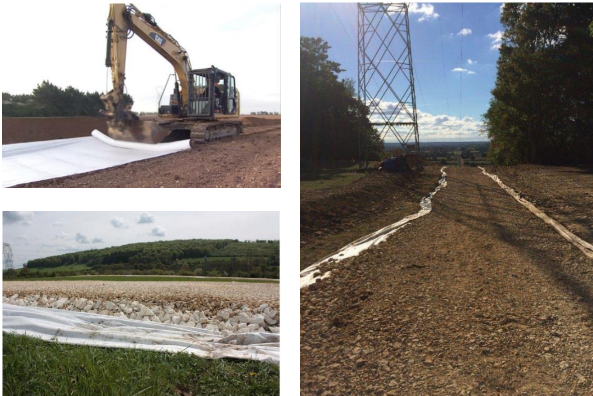
Figure 26 : Illustrations de pistes provisoires
