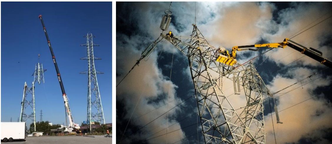
Figure 32 : Exemple de démantèlement d'une liaison aérienne
