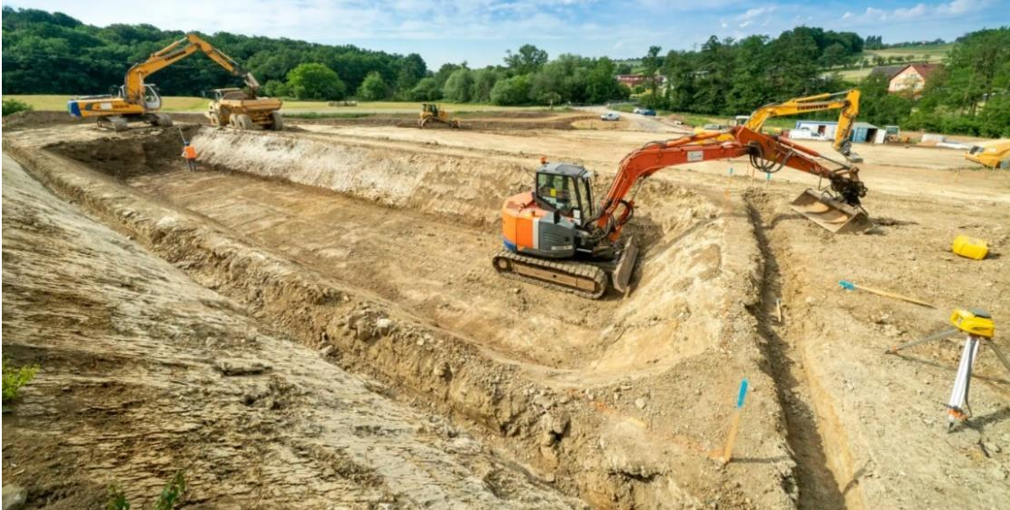
Figure 25 : Exemple de terrassement d'un poste électrique
