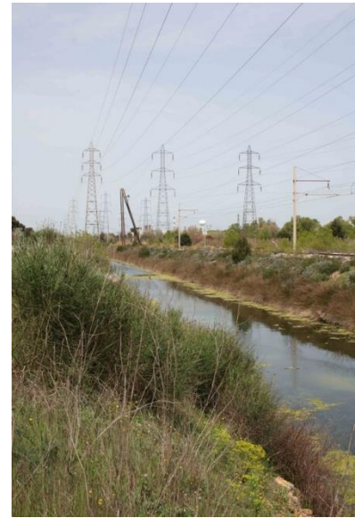
Figure 75 : Roubine de l'aire d'étude le long de la Route du Quai Minéralier.
