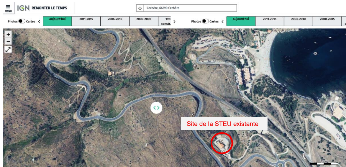
Figure 19 : Site de la STEU à la date actuelle
