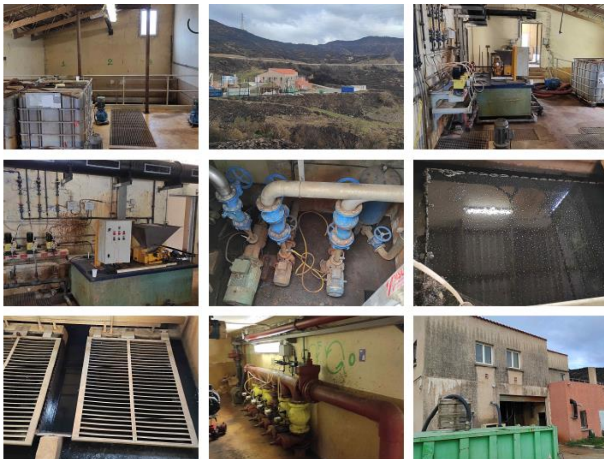
Figure 1 : Relevés photographiques de la STEU existante
