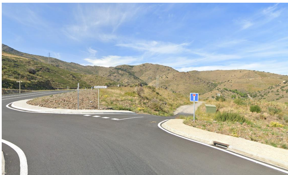
Vue 3 (vue du chemin d'accès à la STEU via la RD 914)
