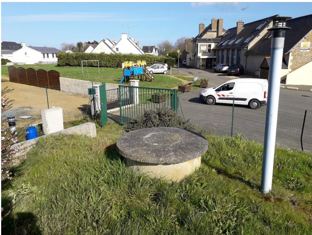
Photo 2 Photos de la station d'épuration actuelle de Lanmodez
