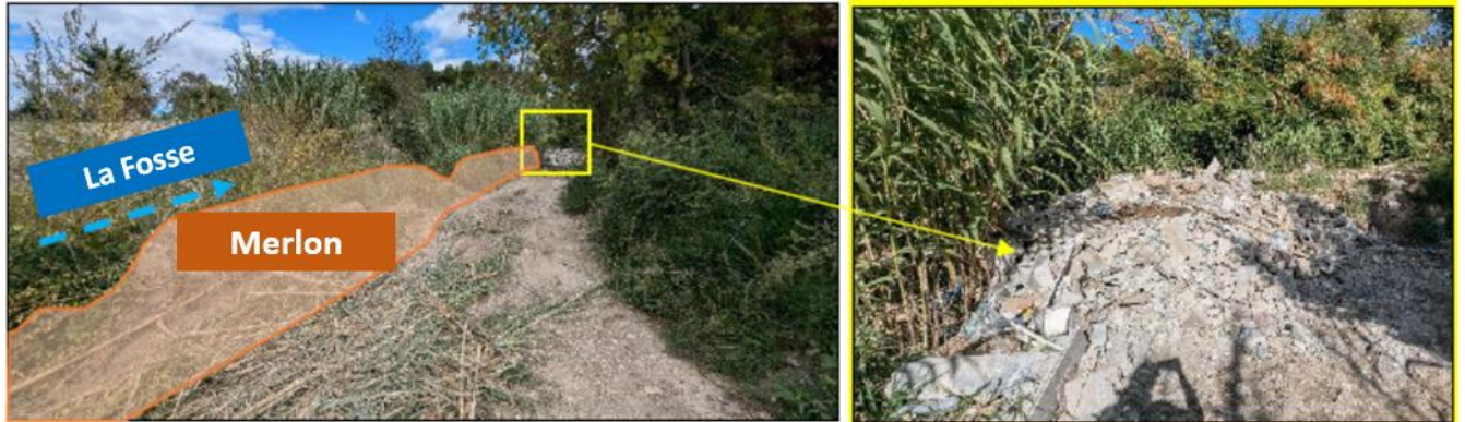
Figure 9 Merlon à araser
