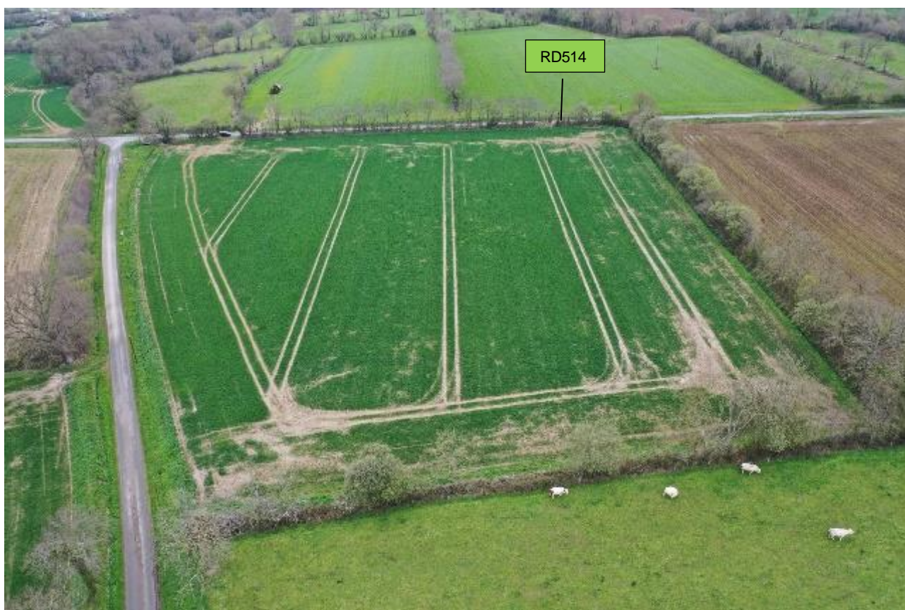
Figure 5 : Vue aérienne de l'ensemble du terrain prévu pour l'implantation de la future station d'épuration
