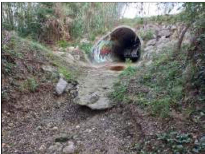
Ouvrage d'art vu de l'aval (03/04/2025)
