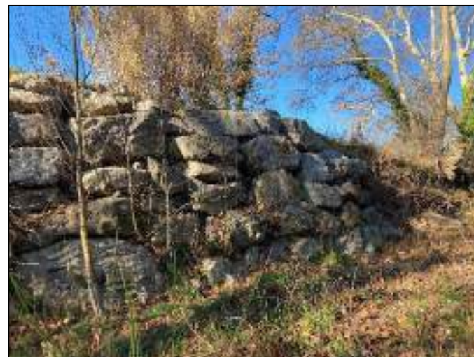
Enrochements verticalisés
