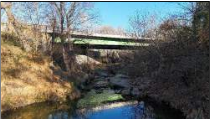
Ouvrage d'art (RN109 sur la Mosson)
