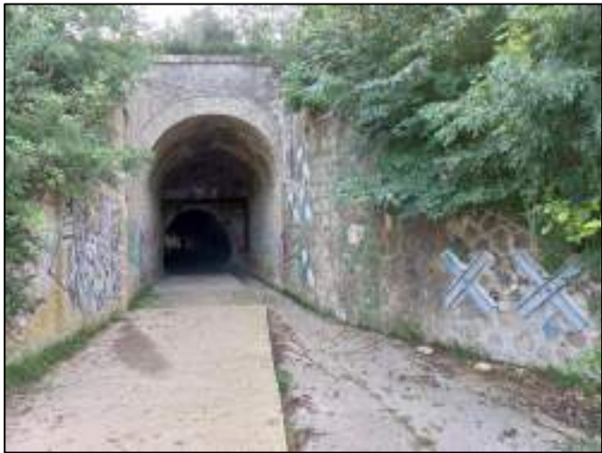
Ouvrage d'art vu de l'amont (03/04/2025)
