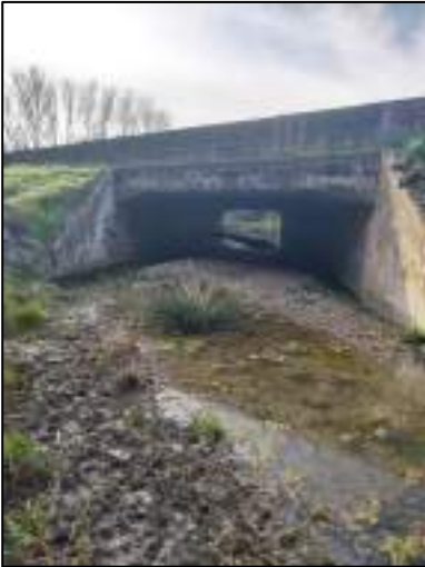
Ouvrage d’art sur la Fosse (04/03/2025)
