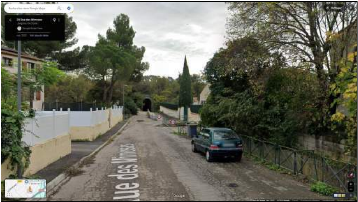
Figure 11 : Ruisseau canalisé (Google Street View, novembre 2022)
