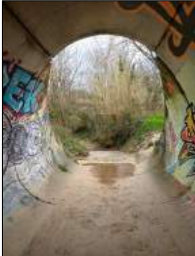
A l'intérieur de l'ouvrage d'art (25/03/2025)
