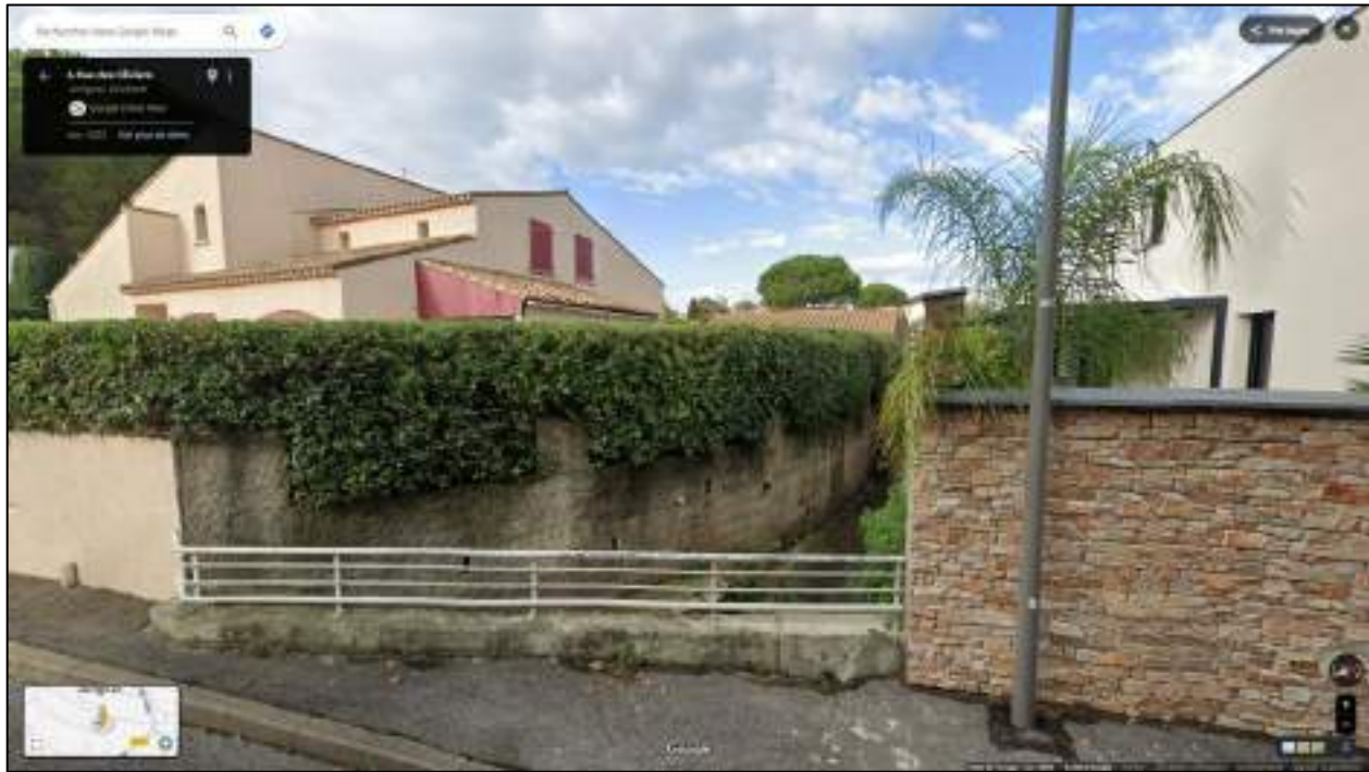
Figure 9 : Ruisseau canalisé (Google Street View, novembre 2022)
