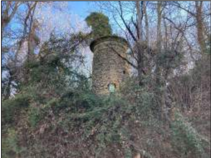
Ouvrage sur la rive gauche
