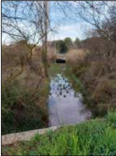
Ouvrage d’art sur la Fosse (04/03/2025)
