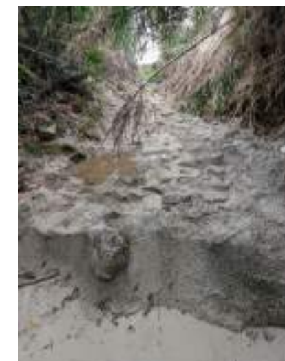
Figure 21 : Rampe de fond vue depuis l'aval
