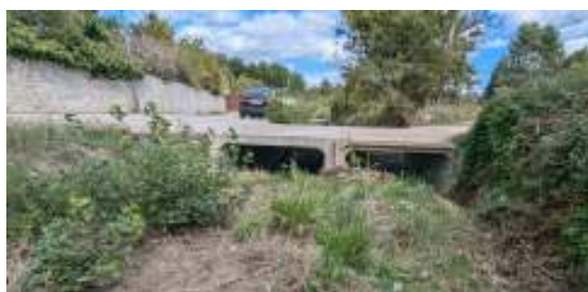
Figure 17 : Pont amont 1 vue depuis l'amont
