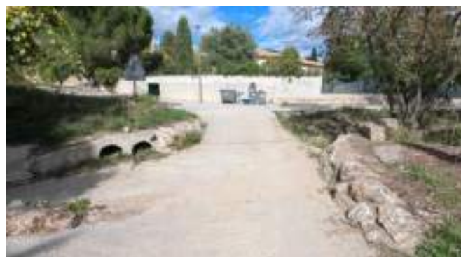
Figure 16 : Gué amont vue depuis la rive droite
