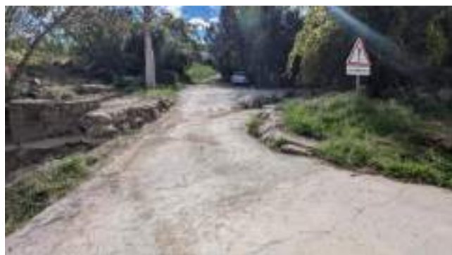
Figure 15 : Gué amont vue depuis la rive gauche
