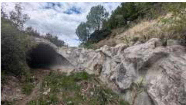
Figure 23 : OH amont RN109 vue depuis l'aval
