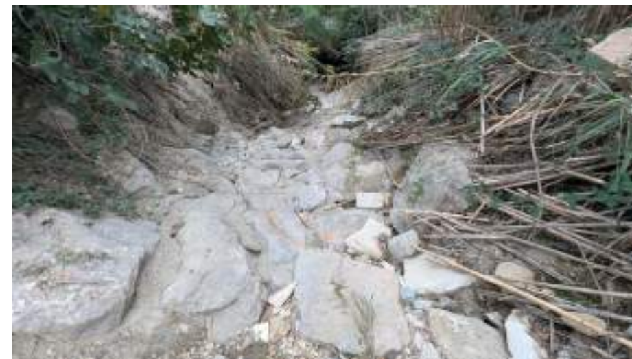
Figure 20 : Rampe de fond vue depuis l'amont
