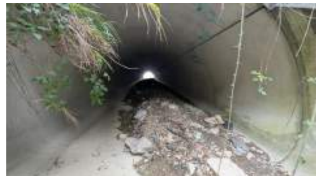
Figure 22 : OH amont RN109 vue depuis l'amont
