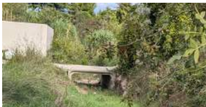
Figure 19 : Pont amont 2 vue depuis l'amont
