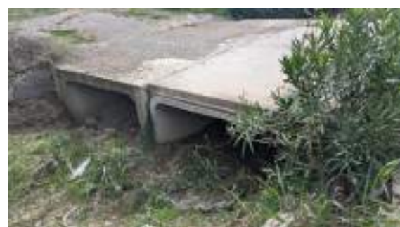
Figure 18 : Pont amont 1 vue depuis l'aval
