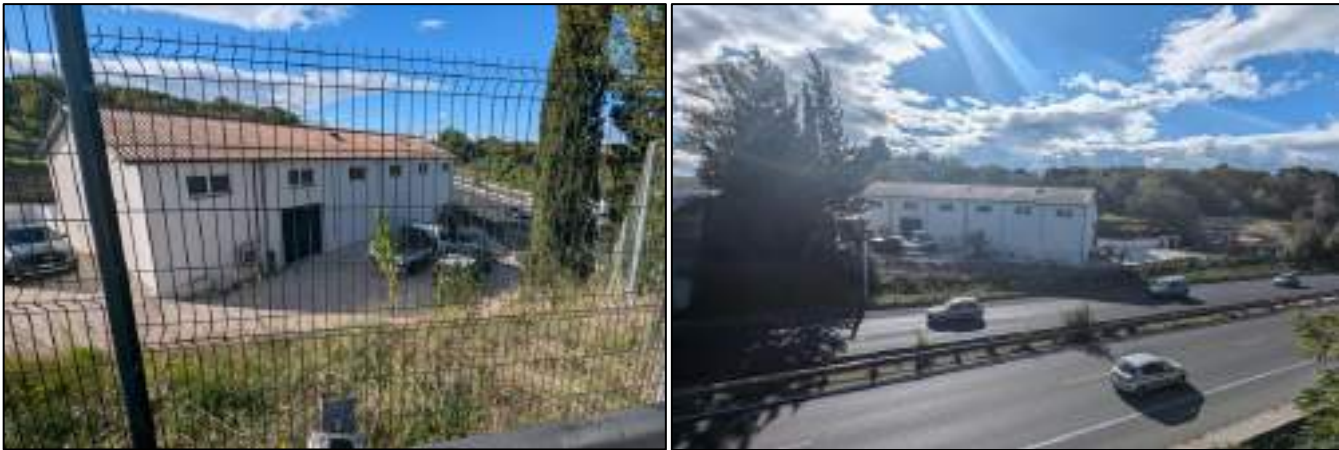
Figure 77 : Bâtiment à démolir au droit de l'emprise du chenal de délestage à réaliser
