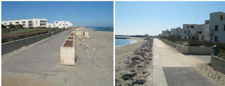
Figure 31 : Erosion de la promenade du Miramar (Le Barcarès), malgré l'enrochement sous-jacent) (SAFEGE, 2013)
