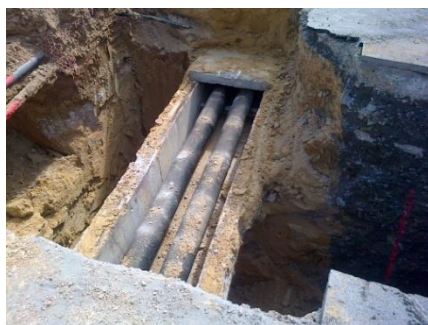
Réseau en caniveau
