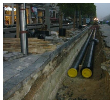
Réseau en pleine terre
