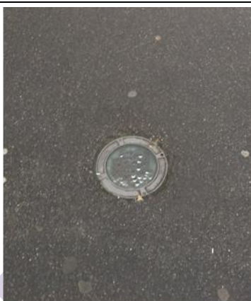
Eclairage par le sol
