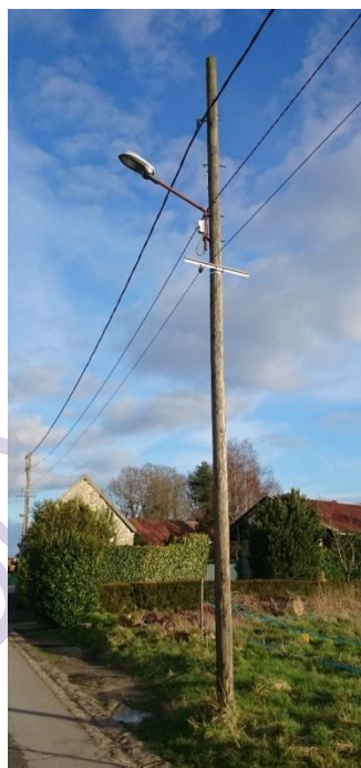
Eclairage public sur support bois commun
