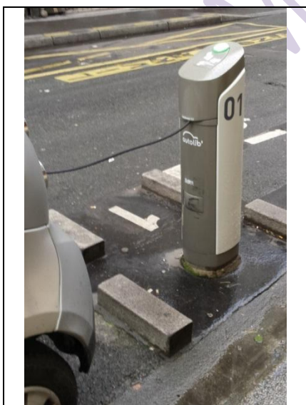
Borne de recharge électrique
