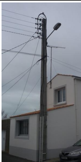
Réseau aérien BT sur support commun
