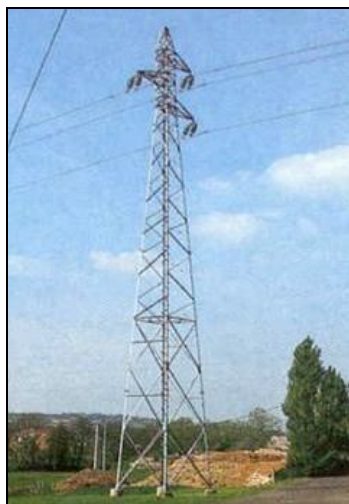
Réseau aérien HTB de 63 kV sur pylône
