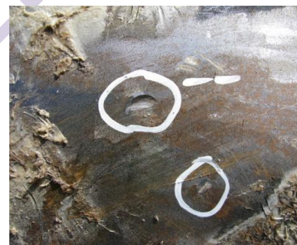
pioche / canalisation acier gaz HP
