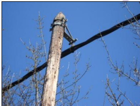
Réseau aérien HTA à conducteurs isolés sur poteau bois
