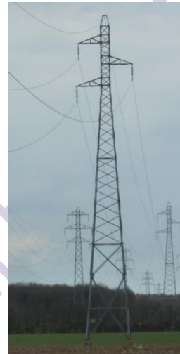
Réseau aérien HTB de 90 kV
