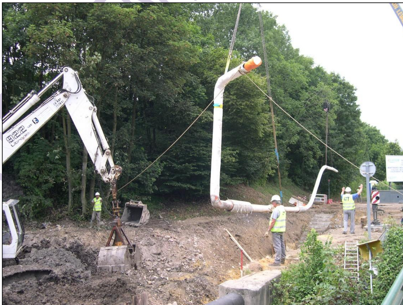
Illustration d'une baïonnette en cours de pose
