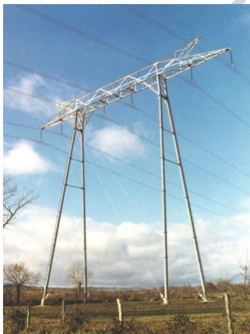
Réseau aérien HTB de 225 kV
