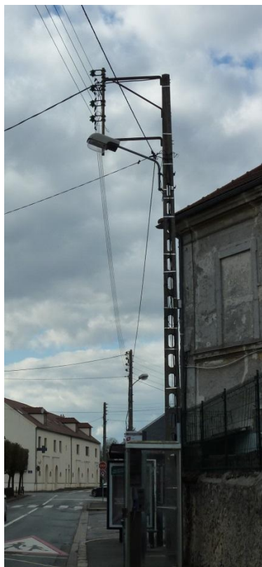
Eclairage public BT sur support béton commun
