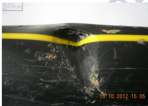
barre à mine / canalisation PEHD gaz MPB
