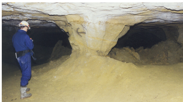
Vue d'un pilier tourné ruiné (source : Ineris)
