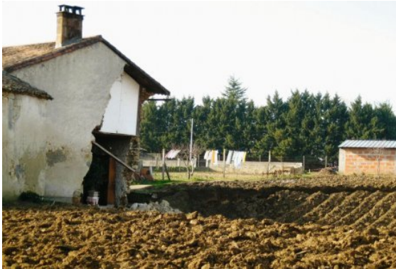
Vues d'effondrements récents : Effondrement d'une carrière souterraine en Gironde (source : site internet de Sud Ouest) et effondrement karstique dans le Var (source : Brgm)
