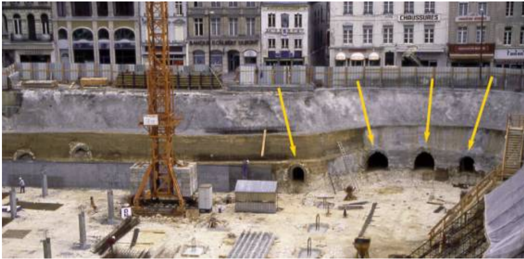
Exemple de cavités découvertes en centre ville au cours de travaux d'aménagement (source : site internet de la ville de St Quentin)
