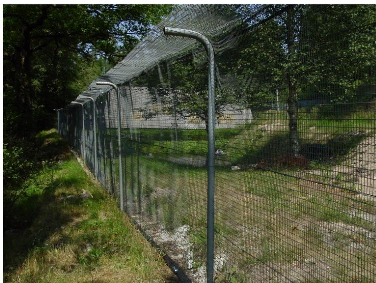
Figure 17b : Clôture de protection avec retour en partie supérieure à Bugeat (Corrèze) (S. Raimond).
