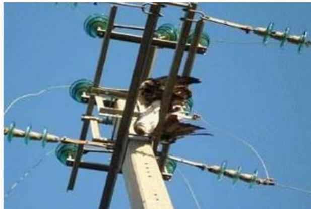
*Illustration 20: Aigle de Bonelli électrocuté sur un pylône électrique -type interrupteur aérien IACM - (C. Audic 2008)*
