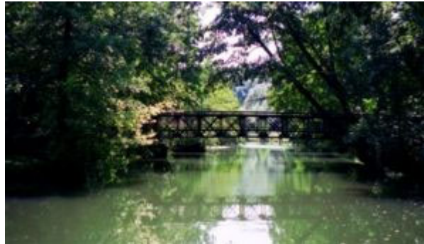
Figure 12 : Passerelle sur l'Yerres
