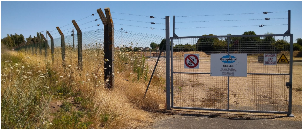
NSL1 : clôture et portail d'accès
