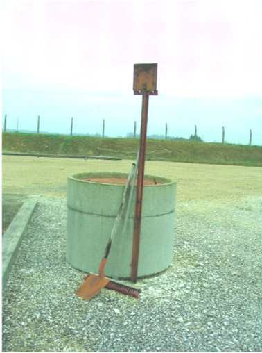
NSL 1 : Sable (lutte incendie)
