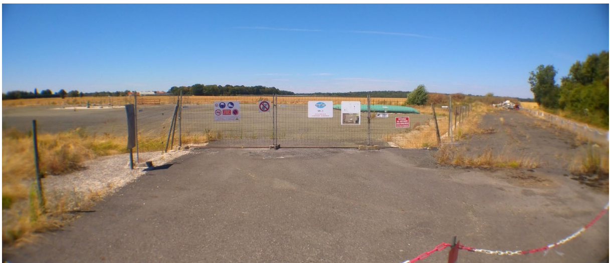
NSL2ST : accès, réserve incendie et tête de puits
