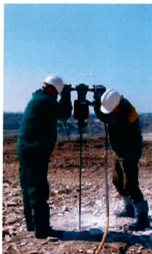
Forage par marteau pneumatique
