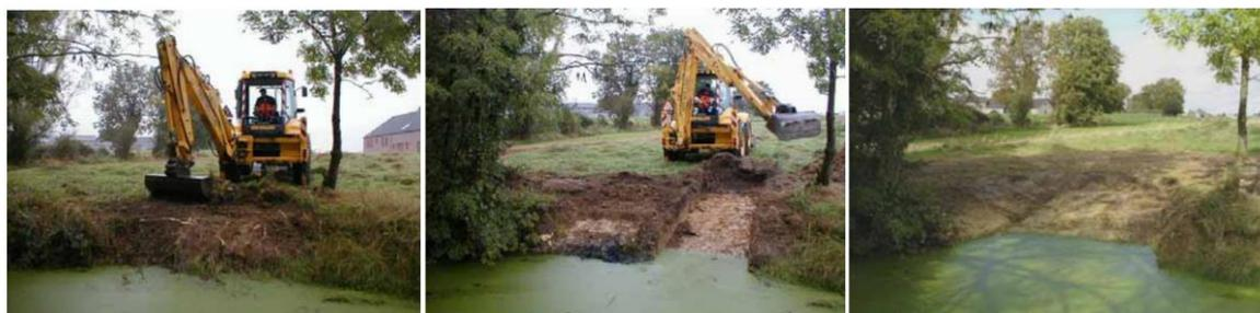
*Photo 11 : Exemple d'intervention en vue du reprofilage d'une berge*
