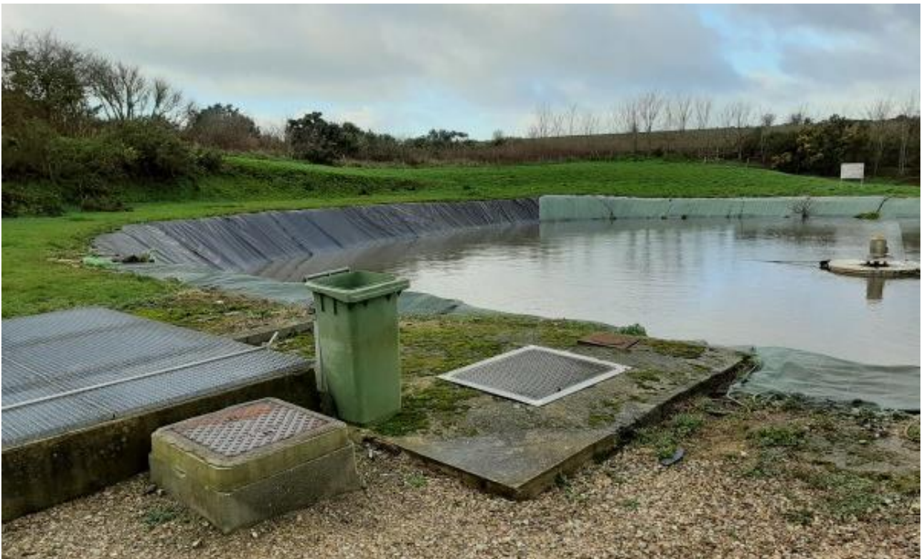
Figure 1 : Station d'épuration actuelle lagune 1, photo du 12/02/2020
